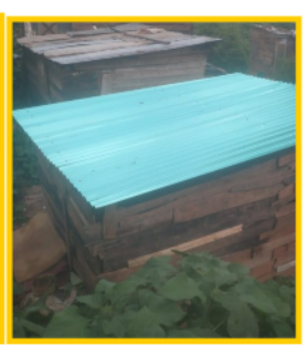
Changement de 8 toitures fin 2025
